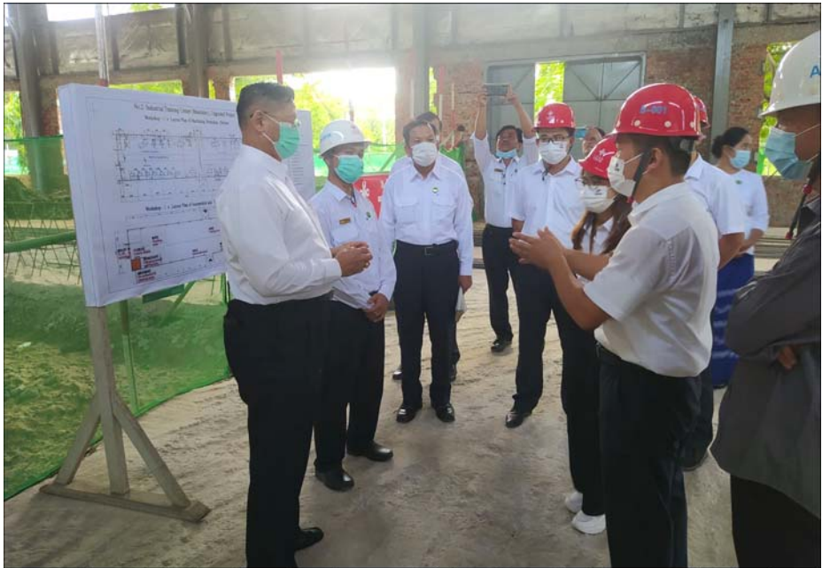
ဒုတိယဝန်ကြီး ဦးရင်မောင်ညွန့် အမှတ် (၂) စက်မှုသင်တန်းကျောင်း(မန္တလေး) အဆင့်မြှင့်တင်ခြင်းလုပ်ငန်းများ ဆောင်ရွက်နေမှုအား ကြည့်ရှုစစ်ဆေးစဉ်။
